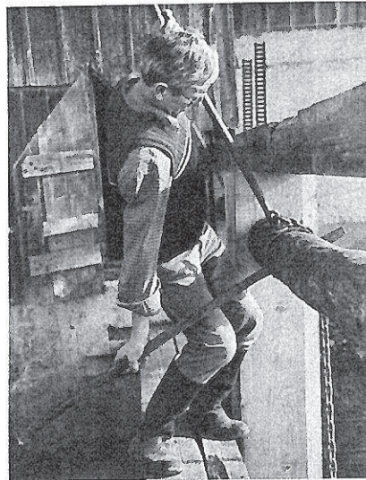
Abb. 3: Eigentümer und Betreiber Willi Renz beim Hochziehen des Fallenstocks
