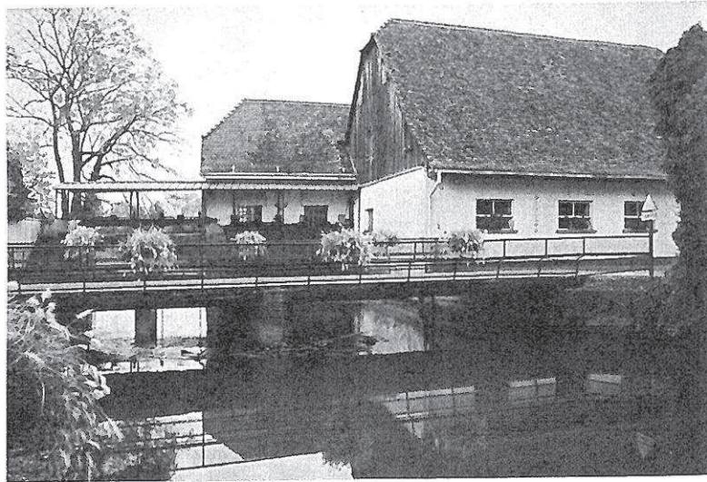
Abb. 8 und 9: Außenansichten von der Wasserkraftanlage der Alsace Génétique im Elsass am Flüsschen Zorn
