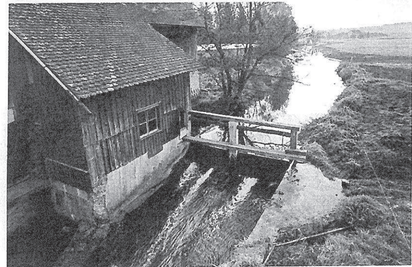
Abb. 2: Das Wehr mit dem danebenstehenden Turbinenhäuschen an der Ablach im Ort Meßkirch
