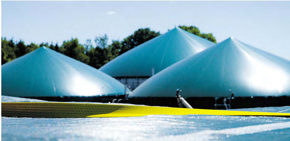
Siloplane auf der Biogasanlage im schleswig-holsteinischen Gönnebek.
