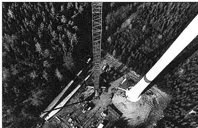
Aufbau einer Windenergieanlage bei Beltheim im Hunsrück.
