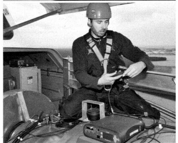
Neue Aufgaben: Neben dem Überprüfen der Anlagenkomponenten, etwa mittels Schwingungsmessungen am Getriebe (unten), wollen die Betriebsführer künftig auch enger in die Dokumentation der Anlagen eingebunden sein.
