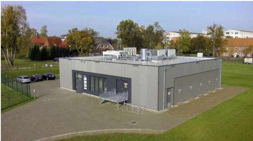
Ein Beispiel für Grossbatterien ist das Batteriekraftwerk des Energieversorgers WEMAG mit einer Leistung von 5 MW und einer Speicherkapazität von fünf Megawattstunden, das zusammen mit dem Batteriespezialisten Yunicos entwickelt wurde. ©Bild: WEMAG
