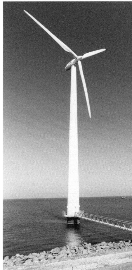
WIND-STEIG: Die Anlagen im Windpark Irene Vorrink stehen nur wenige Meter von der Deichkrone entfernt und können bequem über Stege erreicht werden.
