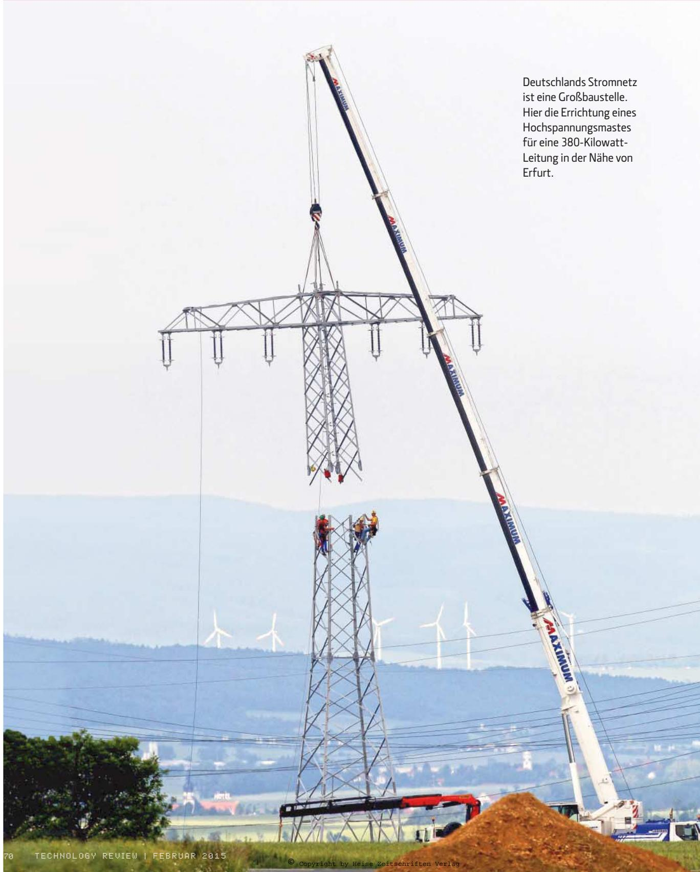
Deutschlands Stromnetz ist eine Großbaustelle. Hier die Errichtung eines Hochspannungsmastes für eine 380-Kilowatt-Leitung in der Nähe von Erfurt.
