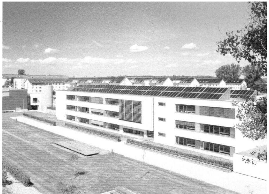
Großprojekt: Im schwäbischen Crailsheim wurden insgesamt 7500 Quadratmeter Kollektorfläche errichtet, auf dem Dach einer Mehrzweck-Sporthalle (links im Bild), auf einem Gymnasium (Vordergrund) und auf fünf Mehrfamilienhäusern (Hintergrund).
