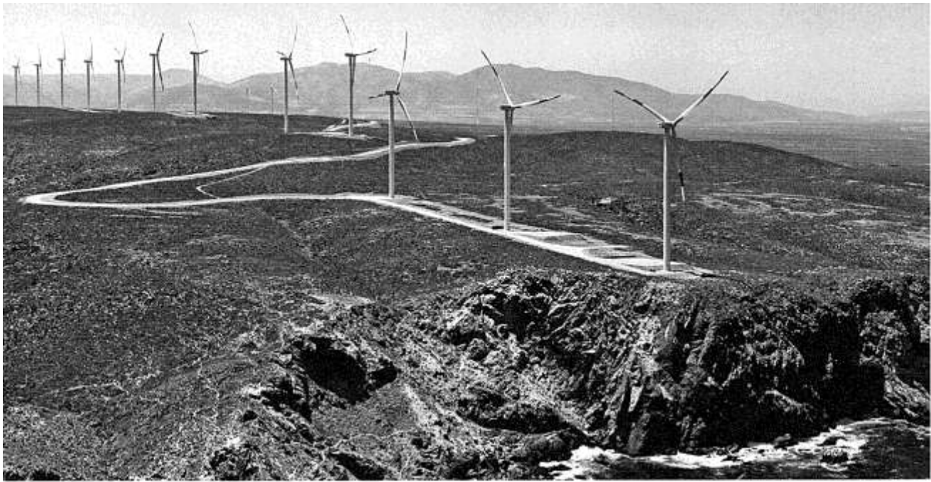
Weites Land, viel Wind: Acciona hat die Anlagen für den 2014 in Betrieb gegangenen Windpark Punta Palmeras geliefert. Mit der Strommenge können bis zu 60 000 chilenische Haushalte versorgt werden.
