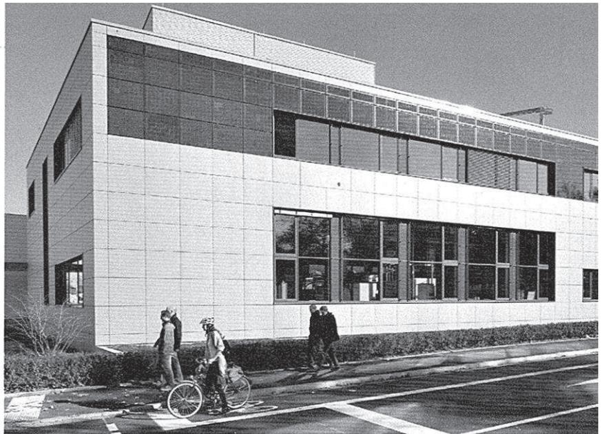
**Selbstgefertigte Hülle:** Ein Laborgebäude des Fraunhofer-Instituts Ise ist seit Kurzem mit speziellen Silizium-Solarpaneelen aus eigener Produktion bestückt.
