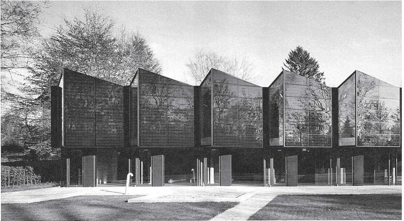
**Maßgeschneidert:** Um die Frontseite dieses Marburger Kindergartens passgenau zu verkleiden, hat die Herstellerfirma die Siliziummodule teilweise in Dreieckform zugeschnitten und die Stromsammelschienen schwarz eingefärbt.
