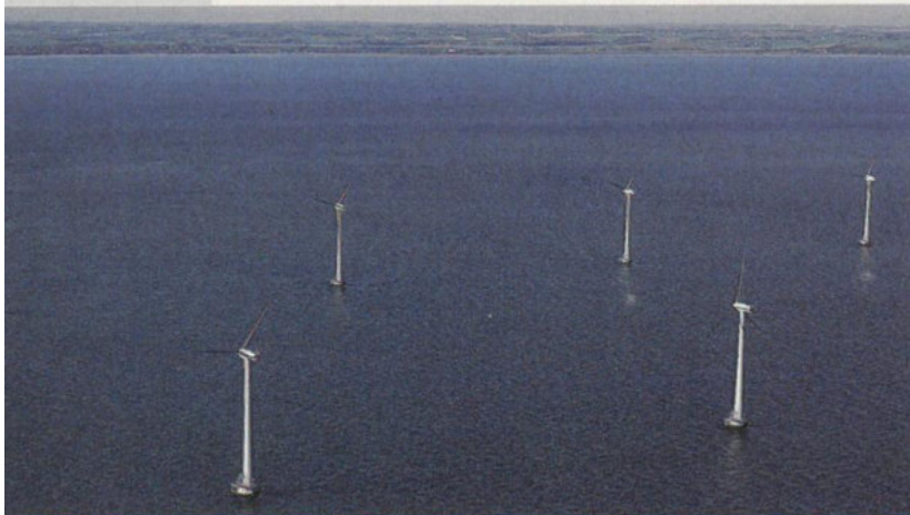
Der Tunø Knob Offshore Windpark an der Ostküste Jütlands wurde im Oktober 1995 an Netz angeschlossen. Er besteht aus 10 Anlagen des Typs Vestas V 39. Das Bild oben zeigt die Aufbauarbeiten mit Hilfe eines Pontonkrans. Fotos: Vestas A/S
