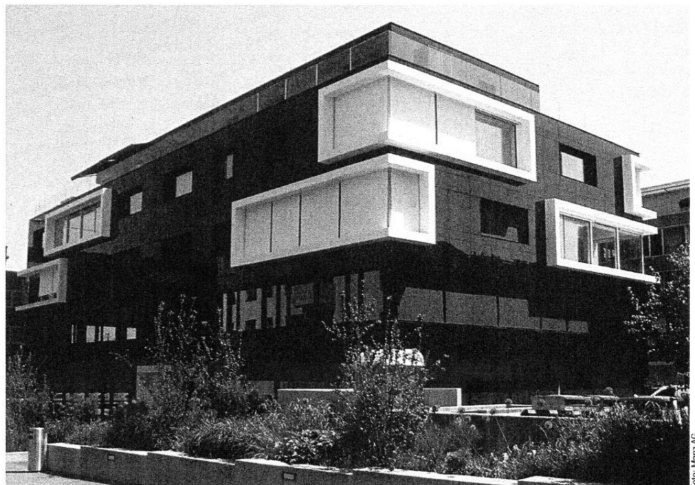
Komplett solar: Dank gut handhabbarer und ästhetisch erscheinender Dünnschichtmodule lassen sich Gebäude vollständig in Solartechnik hüllen.
