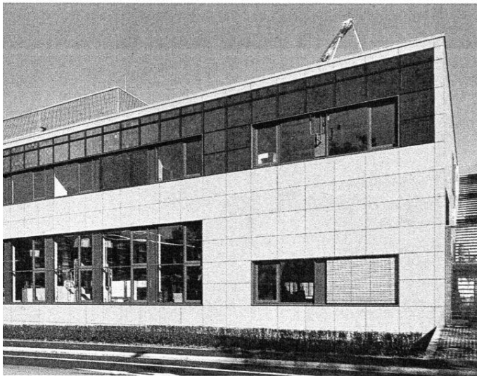
Hocheffizienzfassade: Freiburger Solarforscher testen neuartige kristalline Siliziummodule in der Gebäudehülle ihres Instituts.
