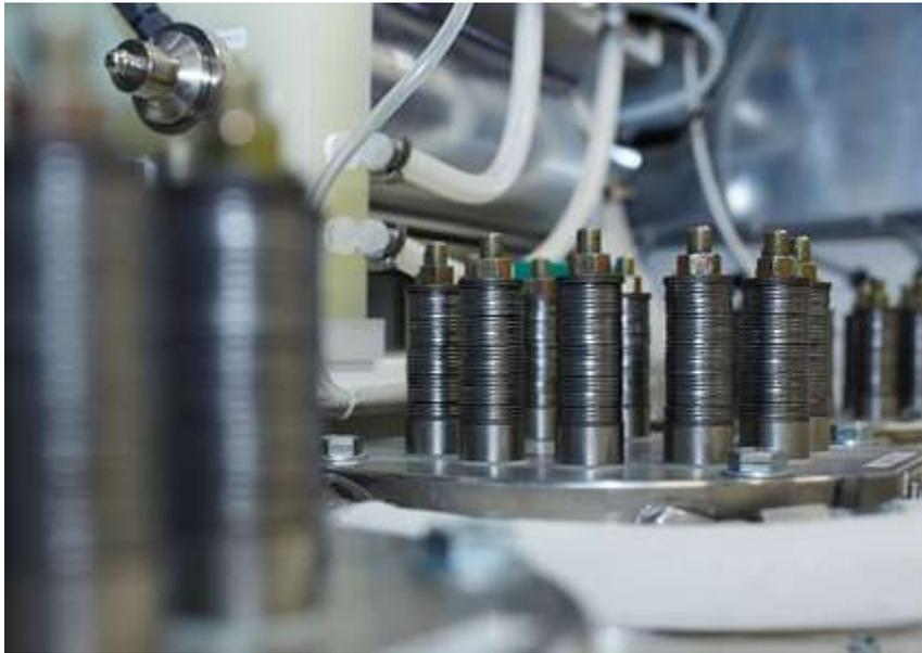
Der Elektrolyseur der Regio Energie Solothurn wandelt überschüssigen Strom in Wasserstoff um, der in Wasserstoffspeicherflaschen zwischengespeichert und dann dosiert ins Erdgasnetz eingeleitet wird. ©Bild: Elektrolyseur der Regio Energie Solothurn
