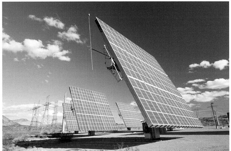
Neueste Technik: Konzentratorsysteme erobern den Markt. Eine Optik bündelt Licht auf winzige Solarzellen, die hocheffizient Strom erzeugen. Bild: Amonix
