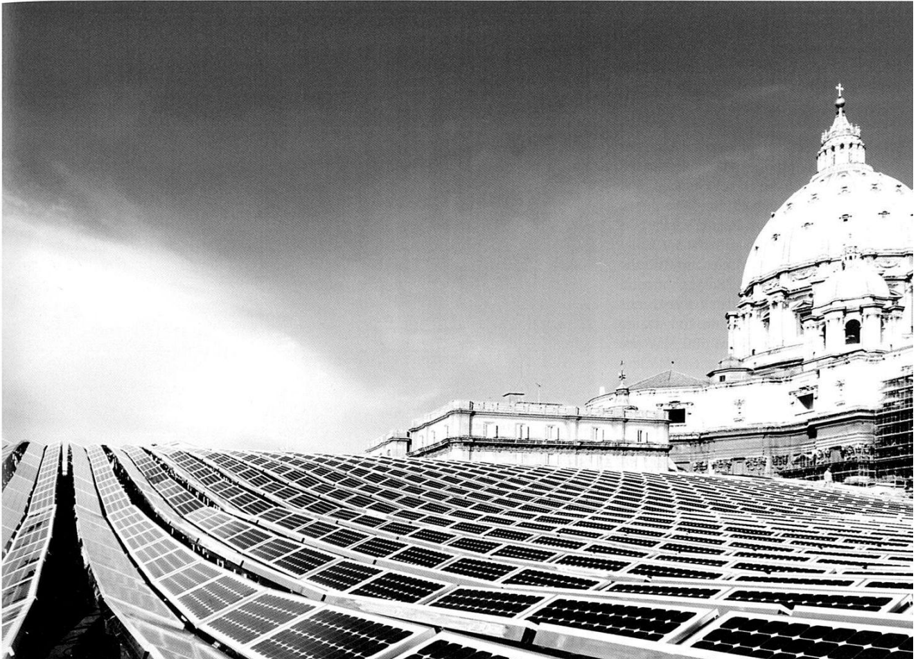
Module für den Papst: Die Länder Südeuropas gelten als Solarmärkte der Zukunft. Doch neben Italien wird bisher nur der Vatikan diesen Erwartungen gerecht. Bild: Solarworld
