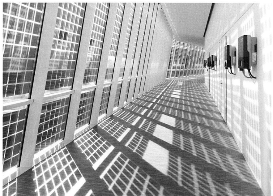
Zukunft der Dünnschicht: Die schlanken Stromgeneratoren sind leicht und flexibel. Damit eignen sie sich gut für die Gebäudeintegration. Bild: SMA
