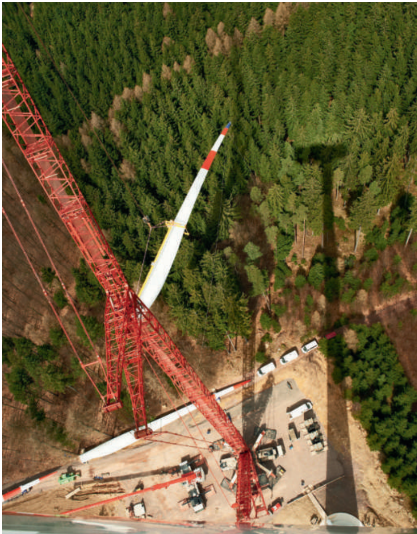
Aufbau einer Anlage des Herstellers Senvion SE (früher Repower) im Windpark Beltheim in der Region Hunsrück.
