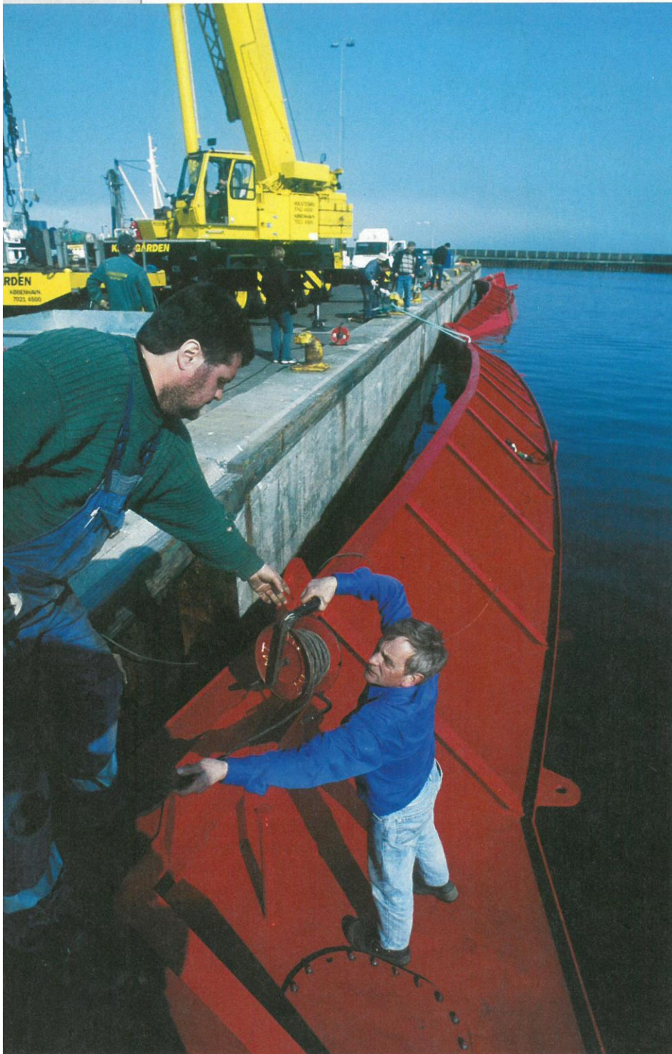
Behutsam zu Wasser: Die beiden je 28 Meter langen Reflektoren des Wellenkraftwerks im Hafenbecken.
