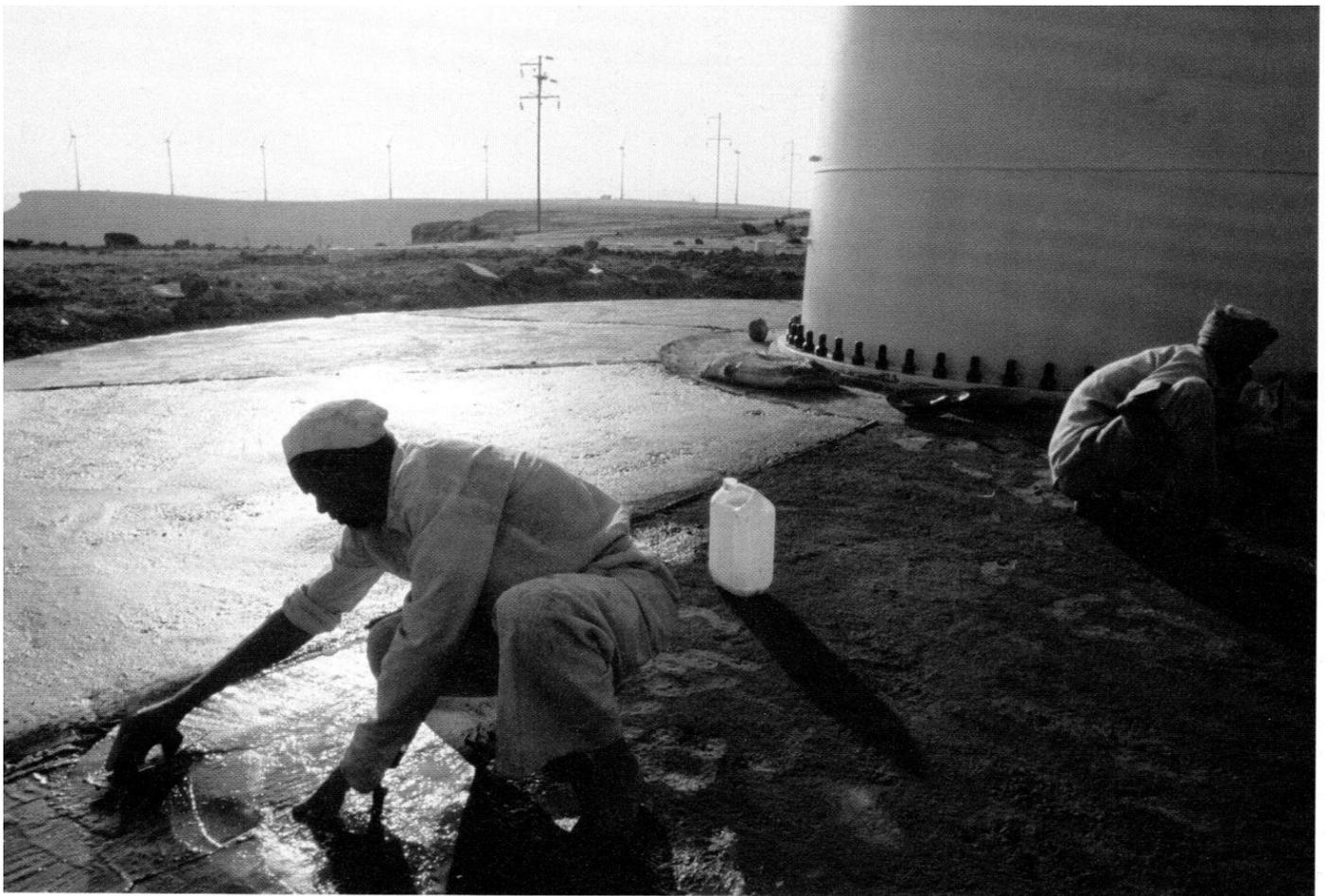
FUNDAMENTAL: Abschließende Arbeiten am Fundament für eine E48 im Windfeld Satara.
