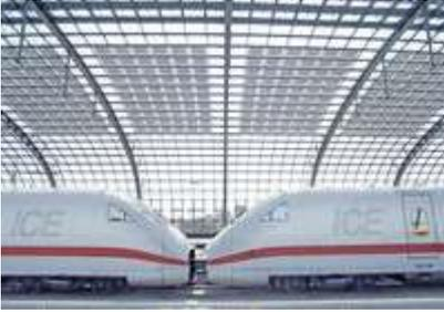
Praxiserprobtes Vorzeigeprojekt: Das Dach des Berliner Hauptbahnhofs verdeutlicht die Vorzüge der BIPV: Die Module erzeugen Strom und lassen zugleich Licht passieren. Bild: BSW-Solar/Paul Langrock
