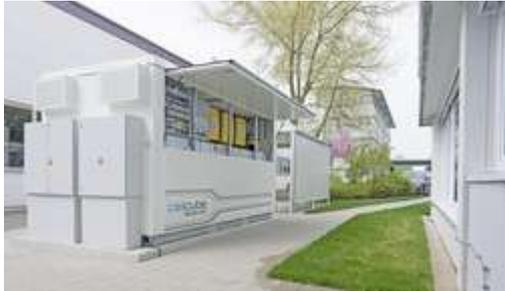
Stromspeicher „CellCube“: Mithilfe der Vanadium-Redox-Flow-Technologie werden große Energiemengen vergleichsweise günstig gespeichert.
