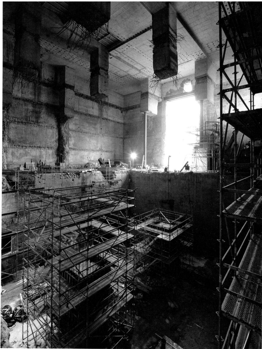
Runderneuerung: Bevor das baufällige Gebäude zum Energiespeicher umfunktioniert werden kann, muss es saniert und mit Pfeilern abgestützt werden.
