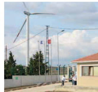
Rund 155.000 Megawattstunden Strom produziert der Windpark Silivri (u.) im Jahr – genug, um eine Stadt mittlerer Größe zu versorgen; (o.): Trafostation.
