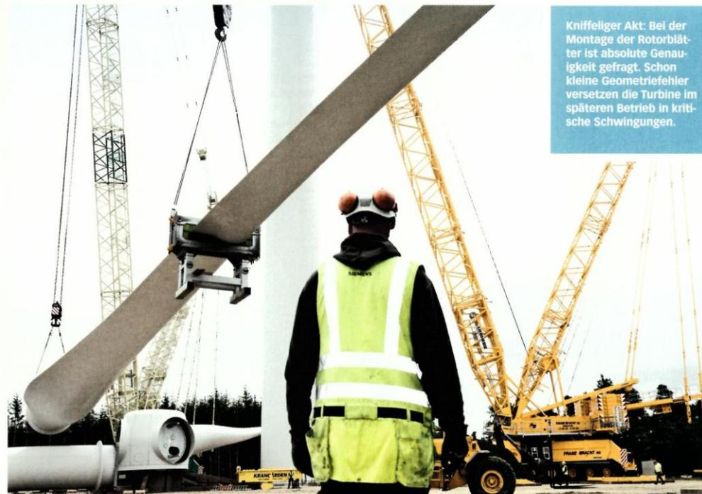
**Kniffliger Akt:** Bei der Montage der Rotorblätter ist absolute Genauigkeit gefragt. Schon kleine Geometriefehler versetzen die Turbine im späteren Betrieb in kritische Schwingungen.
