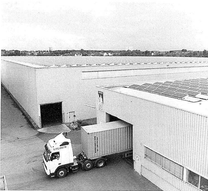
NEUE REIFEN: Die Voltwerk AG hat eine Allianz mit dem Reifenhersteller Michelin geschmiedet. Auf vier Werkshallen in Deutschland, im Bild die 2,6-MW-Anlage im saarländischen Homburg, kann der Projektentwickler aus Hamburg großflächig Module unterbringen – insgesamt zehn MW.
