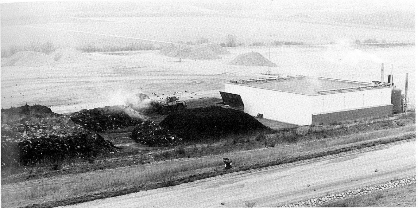
PILOTANLAGE: In München testet die Bekon Energy Technologies seit zwei Jahren eine Biogas-Anlage mit Feststoffen.
