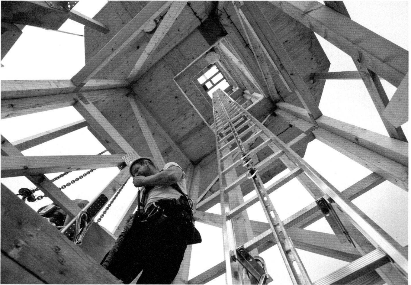
Baugerüst: Das Holzfachwerk im Inneren des Turms dient nur dem Aufstellen der Anlage, für die Statik spielt es keine Rolle.
