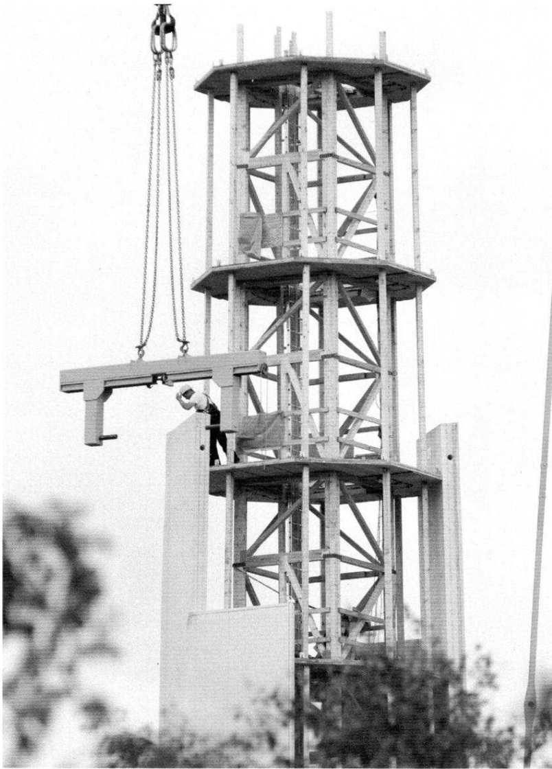
Stückwerk: Der gesamte Turm ist aus einzelnen Fichtenholz-Segmenten zusammengesetzt, die außen mit PVC-Folie überzogen sind (oben). An den Verbindungsstellen der Segmente sind Schlitz für dünne Stahlplatten ins Holz gesägt (unten). Die Spezialbleche sollen einen Teil der Zugkräfte aufnehmen, die auf den Turm wirken.
