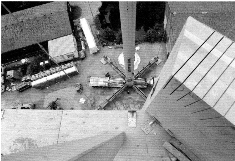
Stückwerk: Der gesamte Turm ist aus einzelnen Fichtenholz-Segmenten zusammengesetzt, die außen mit PVC-Folie überzogen sind (oben). An den Verbindungsstellen der Segmente sind Schlitz für dünne Stahlplatten ins Holz gesägt (unten). Die Spezialbleche sollen einen Teil der Zugkräfte aufnehmen, die auf den Turm wirken.
