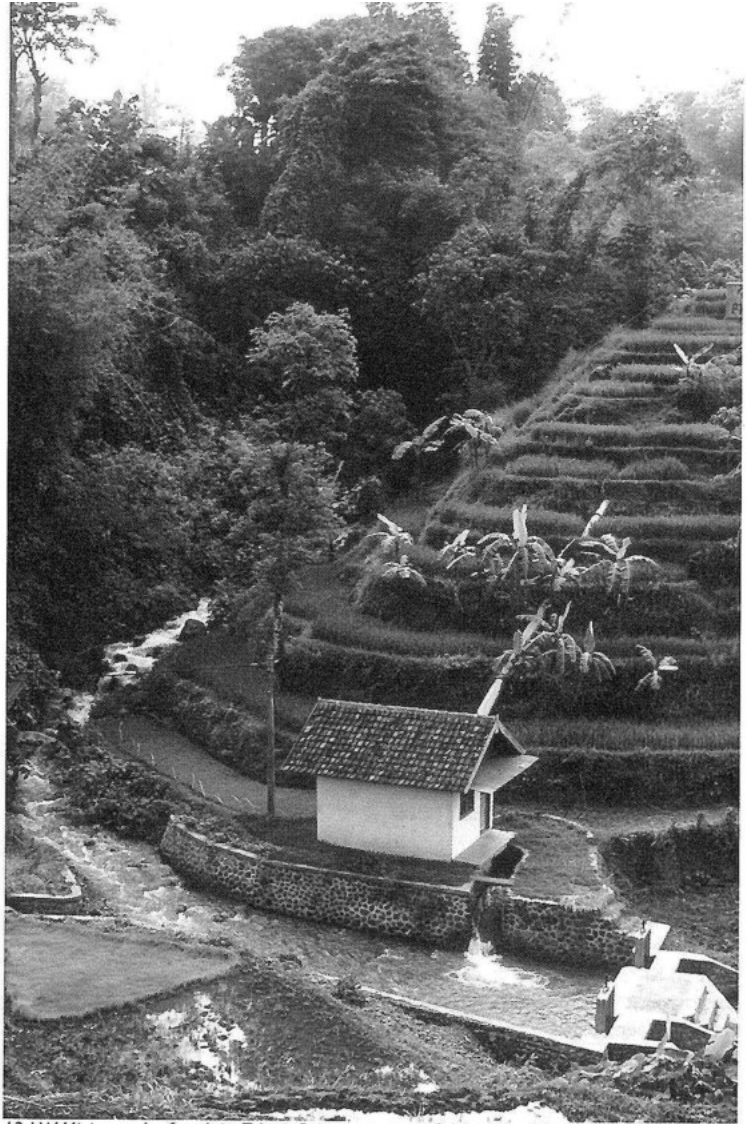
12 kW-Minikraftwerk im Tal mit Reisterrassen von Seloliman auf Ost-Java.
