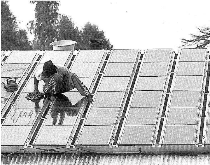
Sauber: Viele tausend kleine Solaranlagen liefern im Senegal sauberen Strom – vorausgesetzt sie werden regelmäßig geputzt.
