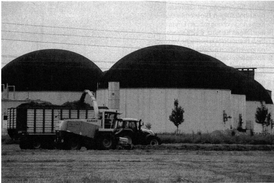
■ Bioerdgasanlage der Schmack Biogas AG.
