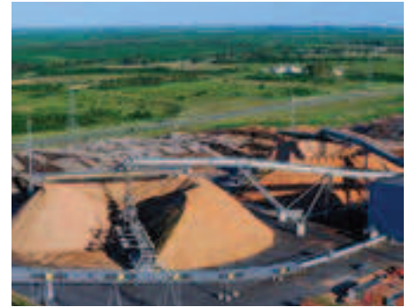
Die Zellulosefabrik Botnia des finnischen Konzerns UPM verschlingt jährlich über 5 Mio. m 3 FSC-Eucalyptusholz. Ein eigenes Biomassekraftwerk produziert 40 MW Strom und Dampf. Im Hintergrund (linkes Bild) der Rio Uruguay und die Grenzbrücke, die Uruguay mit Argentinien verbindet, und die beim Bau des Werkes von Umweltaktivisten blockiert wurde.
