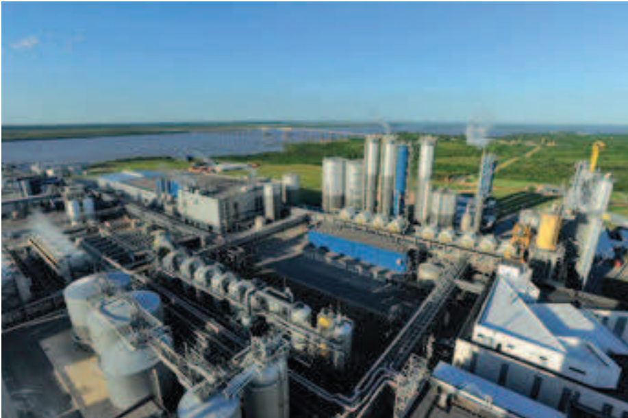
Die Zellulosefabrik Botnia des finnischen Konzerns UPM verschlingt jährlich über 5 Mio. m 3 FSC-Eucalyptusholz. Ein eigenes Biomassekraftwerk produziert 40 MW Strom und Dampf. Im Hintergrund (linkes Bild) der Rio Uruguay und die Grenzbrücke, die Uruguay mit Argentinien verbindet, und die beim Bau des Werkes von Umweltaktivisten blockiert wurde.
