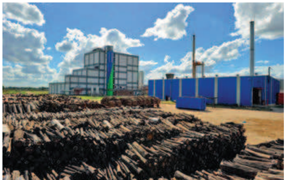
Biomassekraftwerk der Molkerei Conaprole
