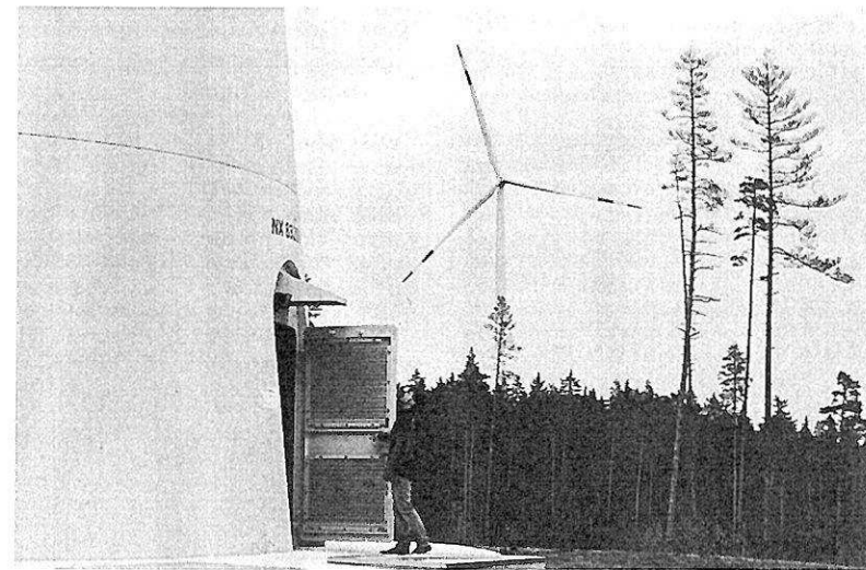
Abb. 4: Der Windpark „Blausäulenlinie“ im Forstbetrieb Waldsassen (Fichtelgebirge) besteht aus drei 2,4-Megawatt-Anlagen des Herstellers Nordex, die im Laufe des Jahres 2014 errichtet wurden.
