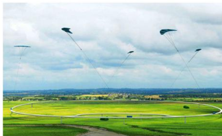
So soll die Anlage aussehen: Die Kites fliegen 300 bis 500 m hoch und sind über 700 m lange Seile mit Wagen verbunden, die sie über einen Schienenrundkurs ziehen. Aus der entstehenden Bewegungsenergie erzeugt ein Generator Strom. Die Steuerungs- und Messtechnik befindet sich auf den Wagen.
