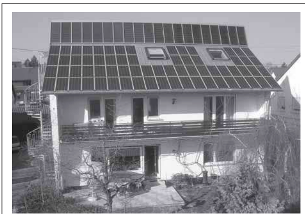
Solardach in Rottenburg Foto: Klaus-Jürgen Lehmann
