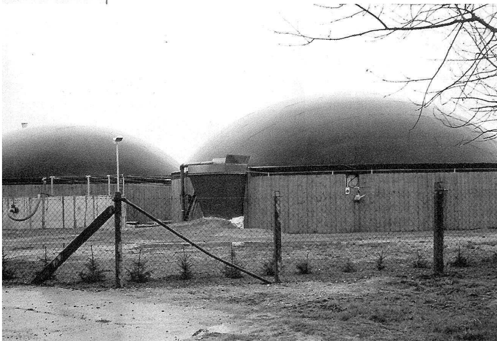
Biogasanlage Thallwitz: Rund 30 Kilometer südlich von Leipzig hat die Ökotec-Anlagenbau GmbH ein 160-Kilowatt-Kraftwerk errichtet.
