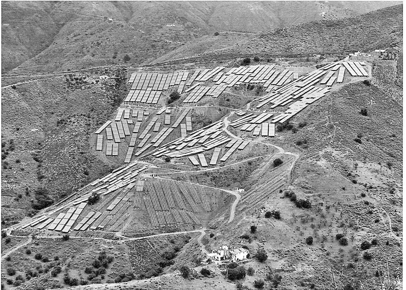
Chaotisches Wachstum: In den Boomjahren wurden große Landflächen in Spanien mit Solarmodulen zugepflastert – oft kreuz und quer, ohne auf eine einheitliche Ausrichtung zu achten, wie bei dieser Anlage in Moclinejo.
