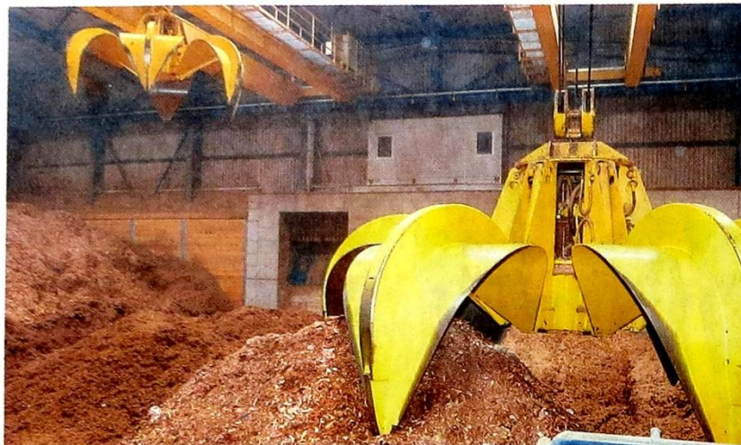
Holzabfälle aus Sägewerken, Zellstoffabriken und Wäldern sind der Rohstoff, aus dem Thüringen den größten Teil seiner regenerativen Energie gewinnt. Foto: H.-G. Oed
