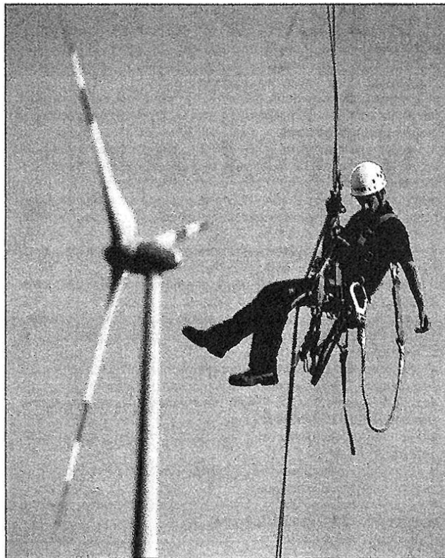
Schwieriger Job: Die Instandsetzung von Windturbinen ist nicht leicht. Für Arbeiten an Flügel und Turm müssen sich die Techniker abseilen.
