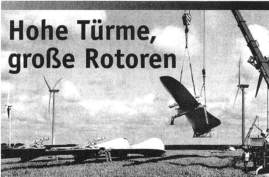
Montage von Rotorblättern mit einem Kran.
