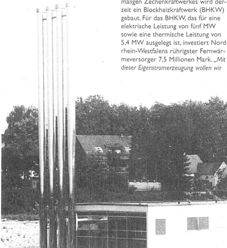
Zu klein geworden: Stadtwerke Herne planen den Ausbau der Grubengas-Energiezentrale.
