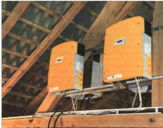
Unterm Dach oder im Keller hängen die Inverter richtig: Sie vertragen keine Hitze. FOTO: SABINE RÜBENSAAT
