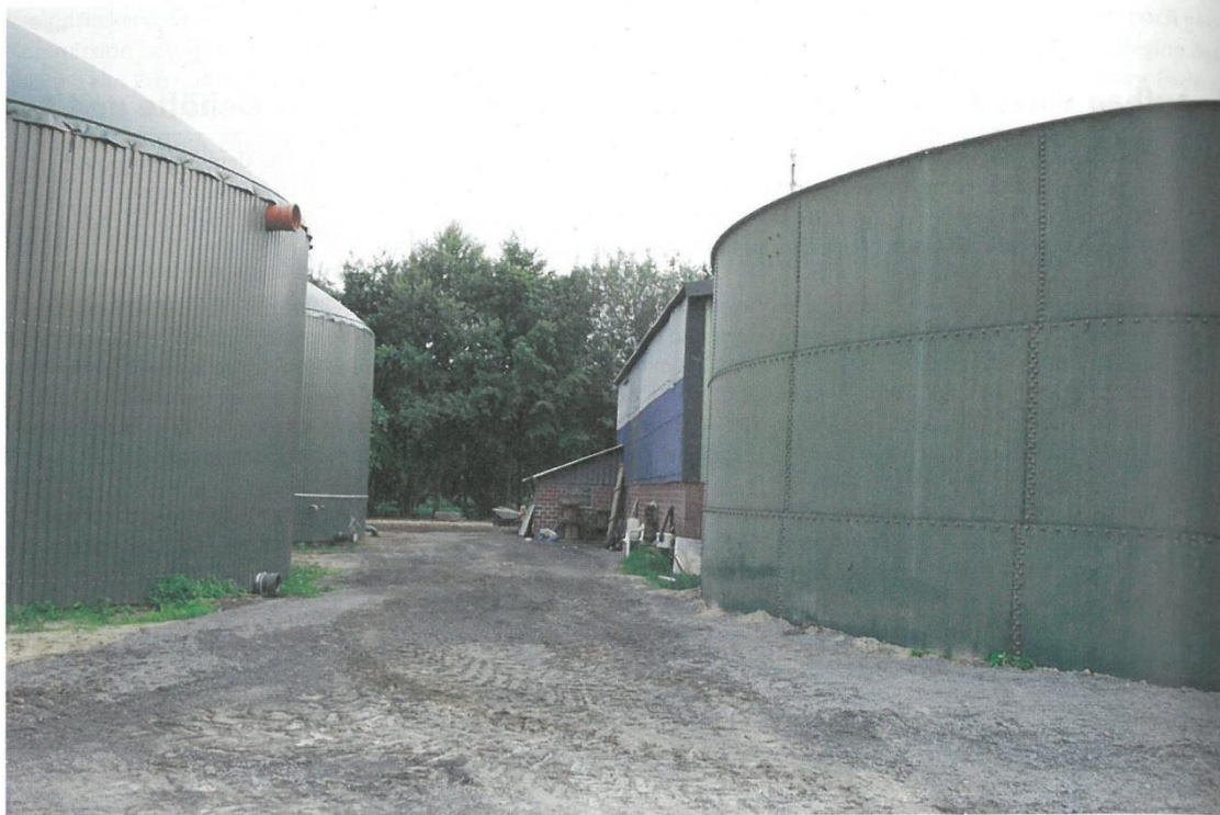
100 kW-Biogas-anlage in Vinte: Das Ökokraftwerk der Firma Osmo-Anlagenbau wurde Mitte September in Betrieb genommen.
