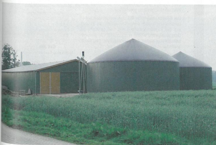
Großanlage im Oldenburger Münsterland: Die 310 kW-Anlage in Düngrup produziert seit Dezember 2001 Strom und Wärme.
