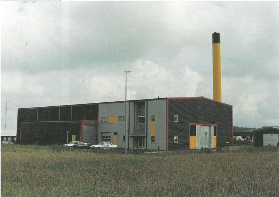
Vorzeige-Anlage: Im 6,3-Megawatt-Heizwerk in Mariager im Norden Dänemarks werden neben Stroh auch Getreidesiebrete energetisch verwertet.
