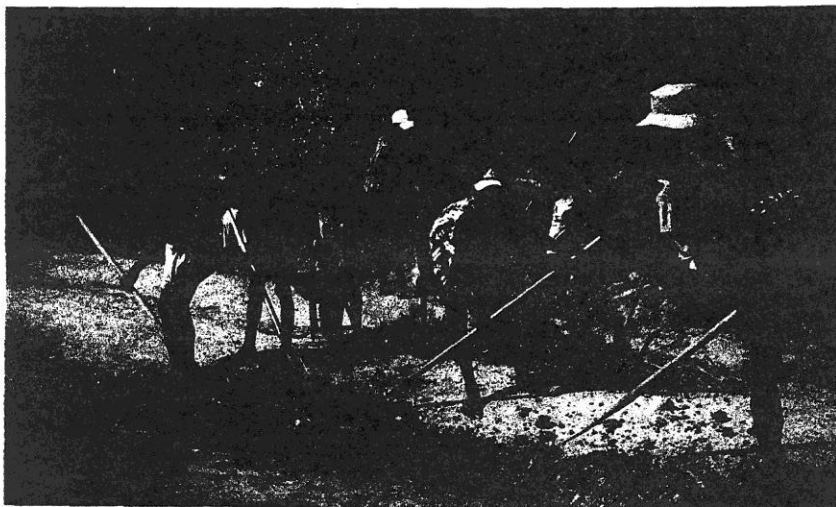
Mit Hilfe einheimischer Arbeitskräfte werden die durch die Stürme zerstörten Straßen instandgesetzt. Für ihre Arbeit erhalten die Männer Lebensmittel. Fotos: Vesper.
