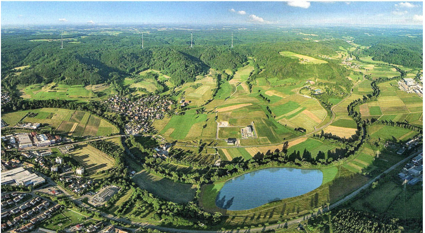
Rekordverdächtig: Mit Nabenhöhen von 155 bis 178 Metern werden die vier Windräder bei Gaildorf zu den größten Windkraftwerken der Welt zählen. Die Simulation zeigt, wie das Mühlen-Panorama am Kochertal Ende dieses Jahres aussehen soll.
