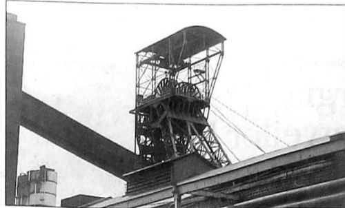
Das Grubengas aus stillgelegten Schächten und Gruben zwischen Rhein und Weser könnte Strom für mehr als 100 000 Haushalte liefern. Foto/Ze: R. Köpke
