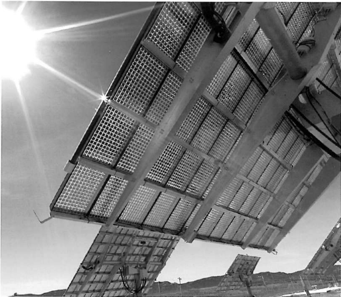
Abb. 5: Mobile Module: Solarsysteme der Firma Concentrix folgen dem Verlauf der Sonne und erzeugen daher besonders viel Strom. Foto: Concentrix
