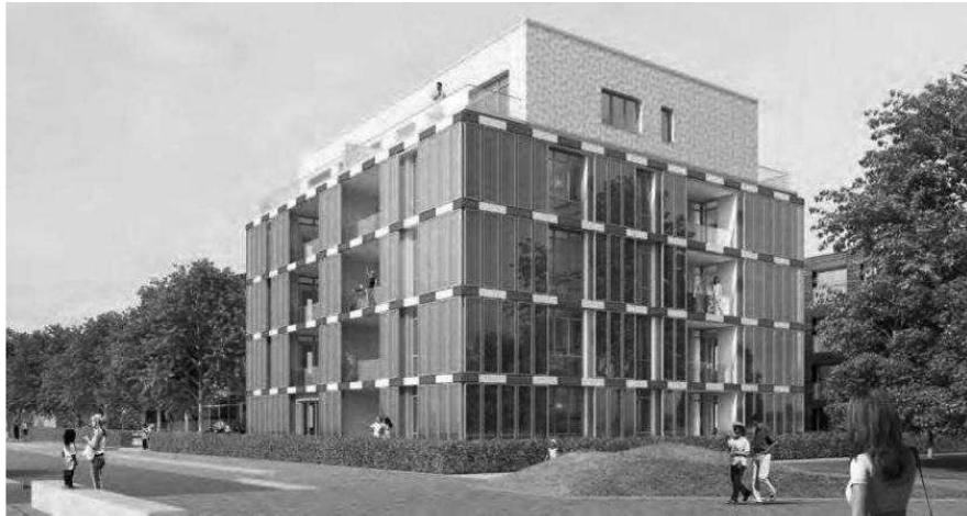
Eingebauter Bioreaktor: Hinter den Glasplatten an der Fassade des fünfgeschossigen Hamburger Neubaus wachsen Algen, die Biomasse und Wärme für die Energieversorgung des Hauses produzieren.
