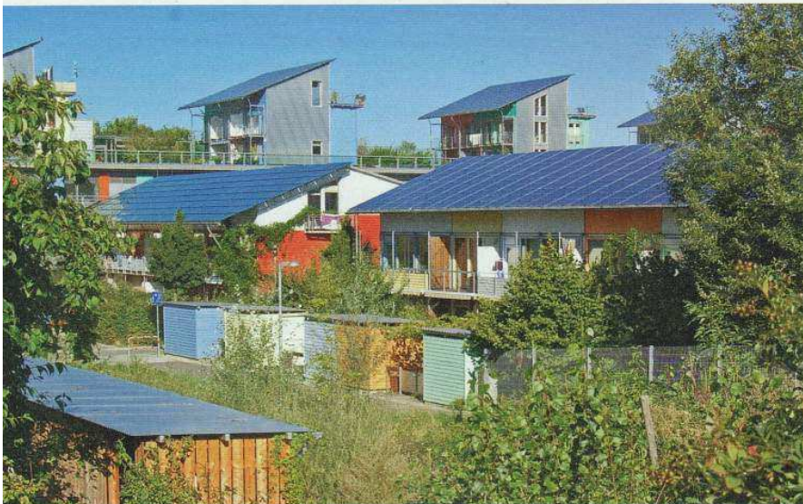
Rasanter Zubau von Solaranlagen in Deutschland.
