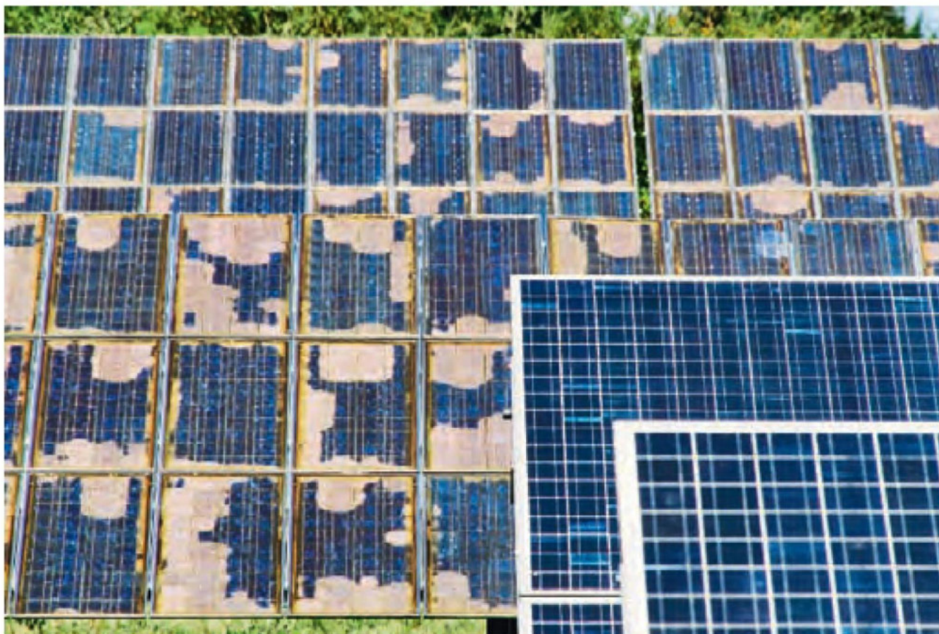
Schlapp gemacht: In der 1988 errichteten 340-Kilowatt-Anlage im Moseltal bei Kobern ist der Leistungsverlust nicht zu übersehen. Die von RWE betriebene Anlage, einstmals Europas größte, ist eine der wenigen mit einer solchen Langzeiterfahrung.
