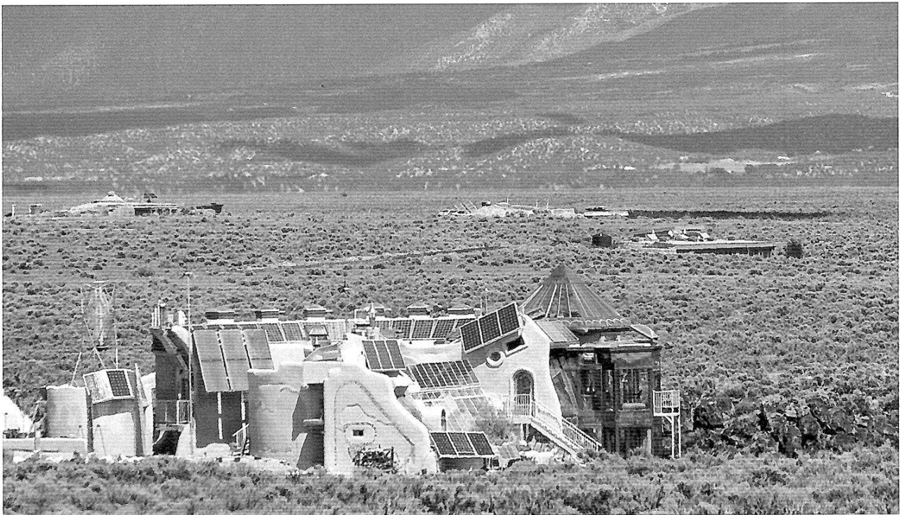
Grid Parity erreicht? Bei Selbstversorgung interessiert die kalkulatorische Größe „Netzstromgleichheit“ nicht.
