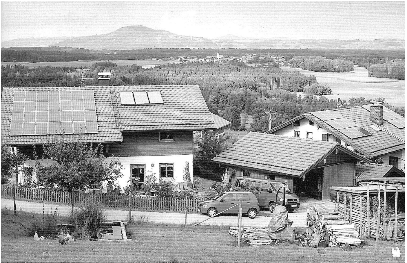
Grid Parity erreicht? Im Süden Deutschlands: ja. Doch zum Selbstläufer wird Photovoltaik wohl nicht.
